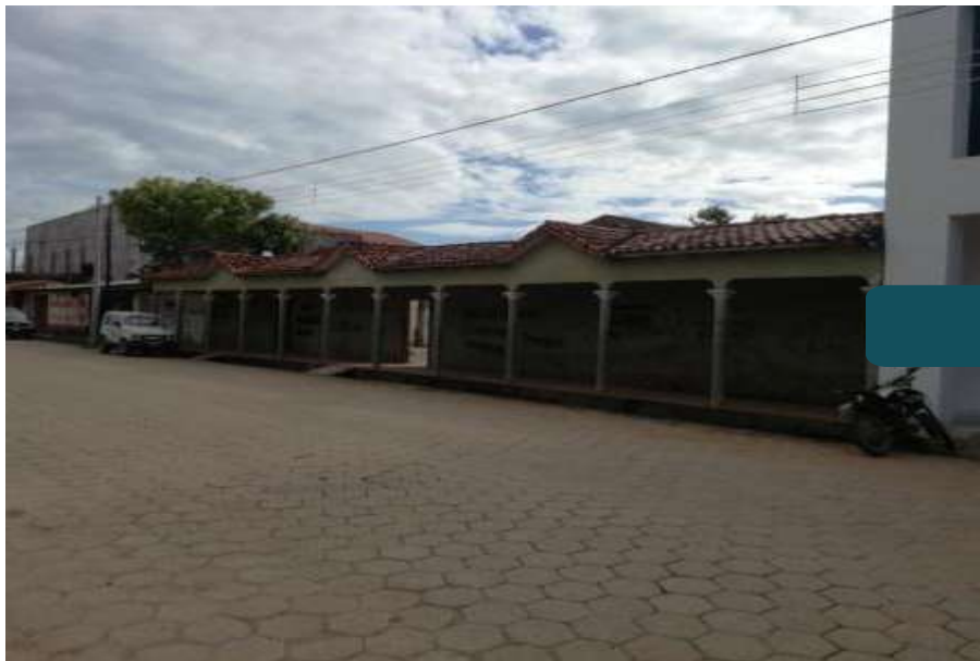
FOTOGRAFÍA ACTUAL DEL INMUEBLE
